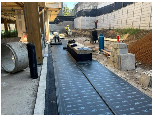
Impermeabilização da área externa
