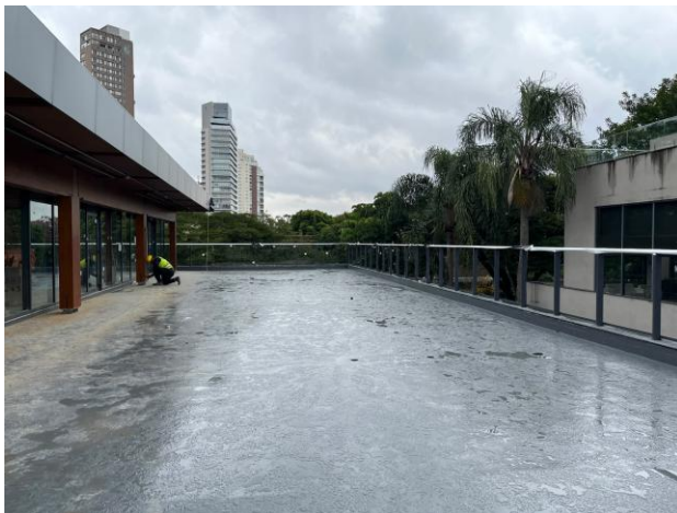
Impermeabilização do terraço
