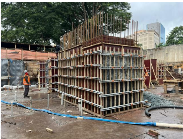
Forma e travamentos do core do elevador - Torre Ferreira
