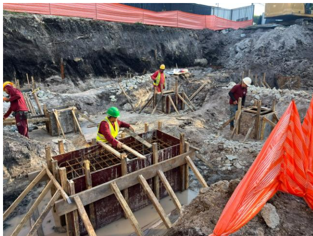
Bloco de fundação - Torre Pedroso
