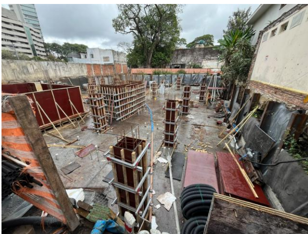
Armação e forma de pilares - Torre Ferreira
