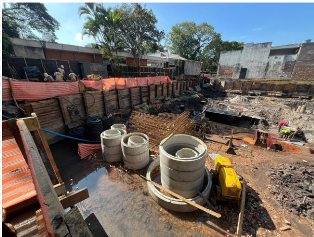
Visão geral - Torre Pedroso
