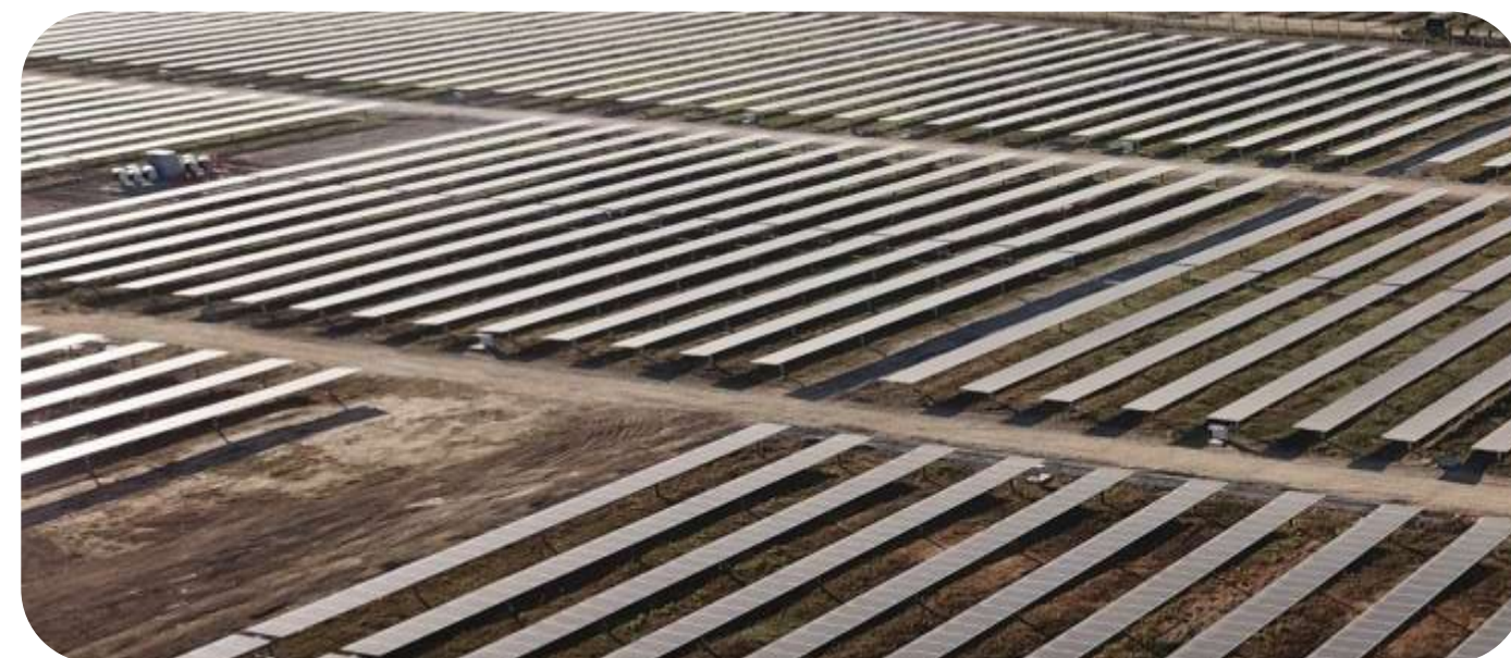
Usina fotovoltaica em Minas Gerais
